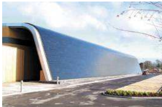
Ενσωμάτωση φωτοβολταϊκών σε δημόσιο κτίριο
