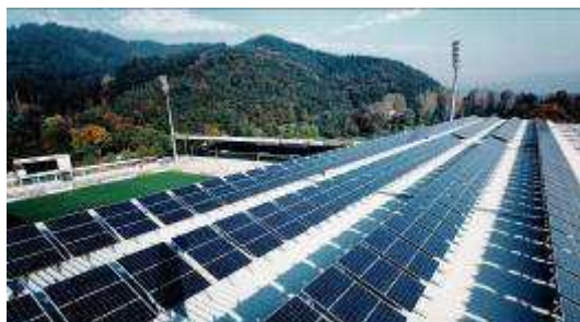
Ενσωμάτωση φωτοβολταϊκών σε γήπεδο ποδοσφαίρου
