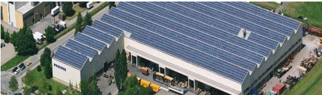
Ενσωμάτωση φωτοβολταϊκών σε βιομηχανική στέγη
