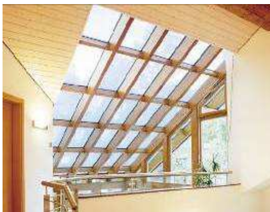
Διαφανή φωτοβολταϊκά σε στέγη κατοικίας επιτρέπουν τη διέλευση του φυσικού φωτός
