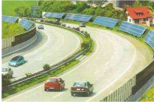
Εφαρμογή φωτοβολταϊκών σε ρόλο ηχοφράγματος σε αυτοκινητοδρόμους
