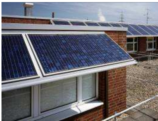
Φωτοβολταϊκά σε ρόλο σκιάστρων
