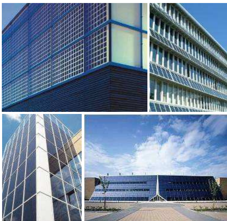
Εφαρμογές φωτοβολταϊκών σε προσόψεις κτιρίων
