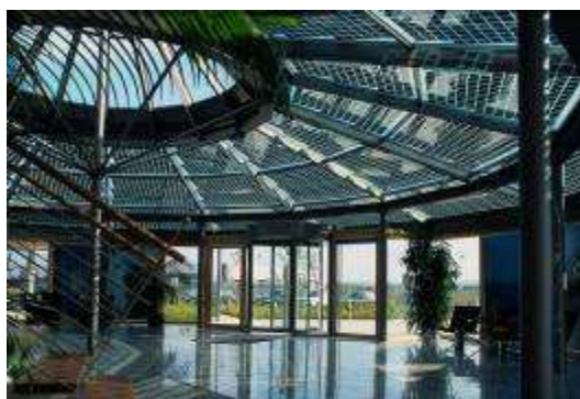
Εφαρμογή φωτοβολταϊκών που επιτρέπουν τη διέλευση φυσικού φωτός σε εμπορικό κτίριο
