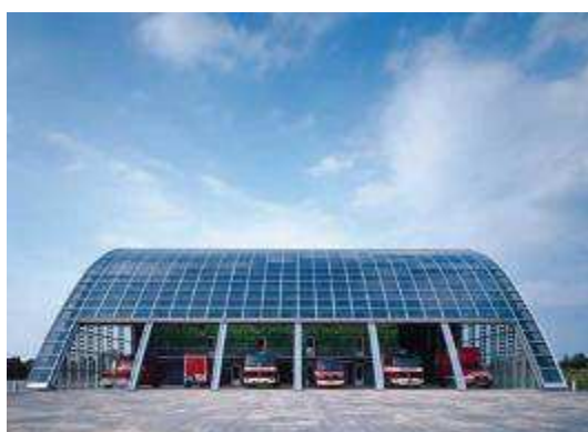
Ενσωμάτωση φωτοβολταϊκών σε πυροσβεστικό σταθμό
